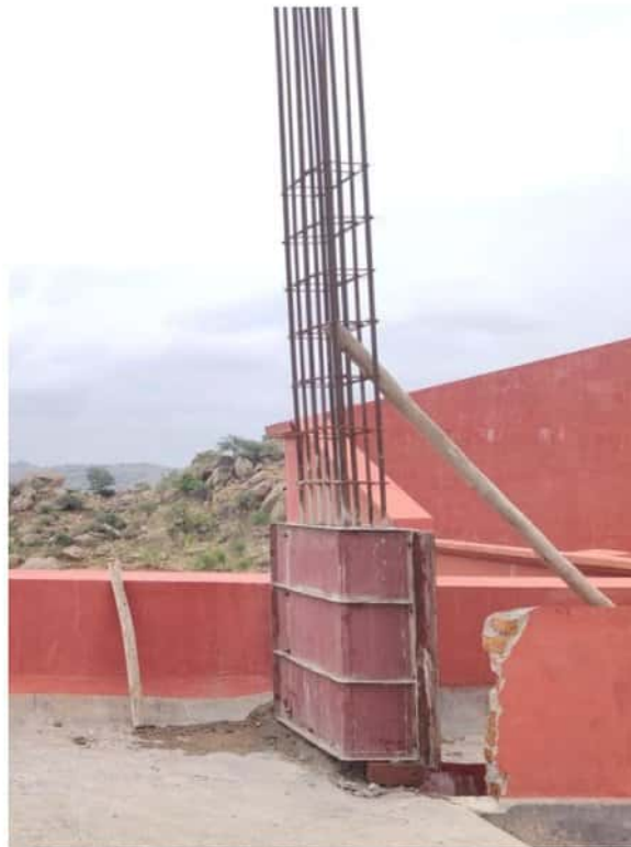
Fig:4.1 SHUTTERING
